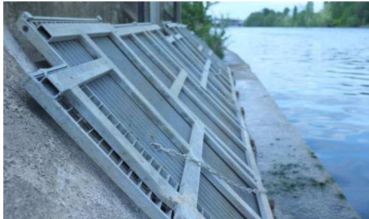
Courbevoie, lundi. Voici une prise d'eau installée sur les quais de Seine. Elle permet à la Société urbaine de climatisation (SUC), chargée de la climatisation d'une partie du quartier d'affaires (photo de droite) de pomper l'eau du fleuve. (LP/S.R. et DR)
